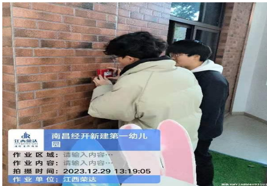
图 5-7 学校学生在南昌经开新建第一幼儿园维修消防设备
